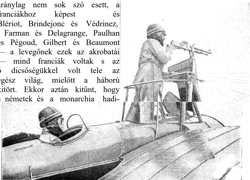
Hadirepülőgép, amelyre golyószóró van szerelve. Míg az egyik aviatikus a gépet a másik célba veszi az ellenséget és golyószóróval lövöldöz rá a levegőből.
