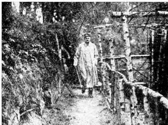
Flandriai német lövészárók, melyet oldalt csatorna szegélyez. A lövészárókba beszivárgó vizet így kellett levezetni egy távolabbi mély gödörbe
