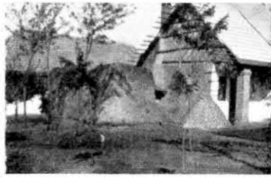
12. ábra. Épülő sárfalú ház.
