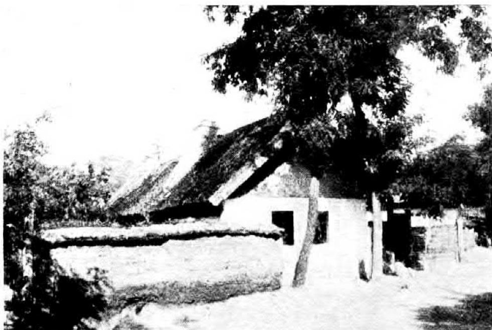
32. Nádalt kéményű ház Fényszarun. Jellemző a táj építőanyagaira a nádfedél, sárkerítés, amelyet kukorica-kóró fedél takar.
