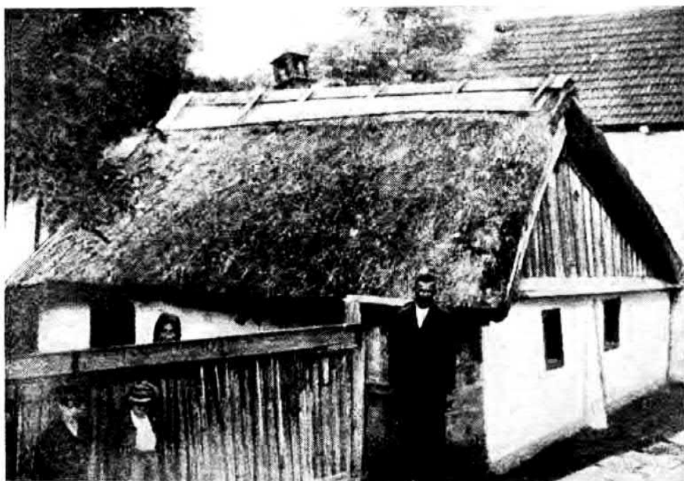
24. Putriház Árokszálláson, a Gyóni-utcában. A félig földbe süllyesztett ház homlokfalának aljában még jól kivehető a villás-fának a falból kiugró alja.
