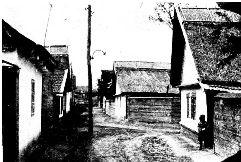
60. Berény zsúfolt településű része a kertés-város korának belső, emberi lakó-településű részében, típusos gazdaházakkal.
