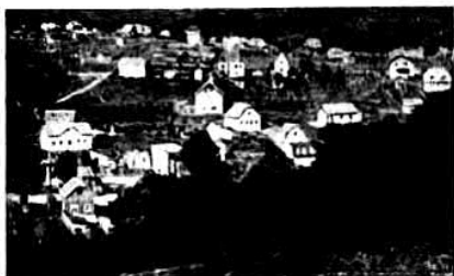
6. Zavaros benyomást keltő, rendszertelen, ú. n. „vad-építkezés”.
