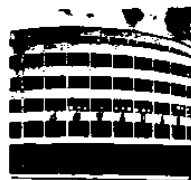
44. A pillérvázis építésmódnál inkább kialakódnak a pilléreknek megfelelő széles ablakok.
