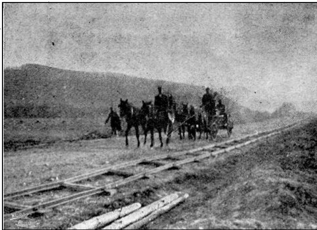
Tábori vasúti vonal építése a Kárpátokban.
