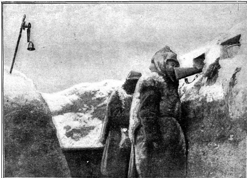
Riasztó csengő, amely éjjeli támadásoknál jelzi a drótsövénnyel érintett ellenséget.
