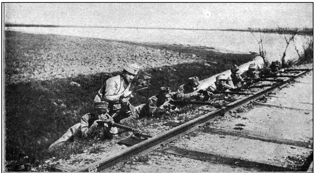
Vasúti őrség Kolomea mellett.
