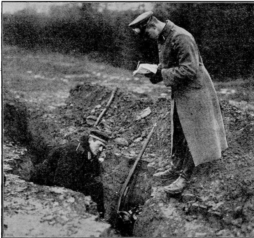
Földalatti telefonvezeték elhelyezése és kipróbálása Belgiumban.
