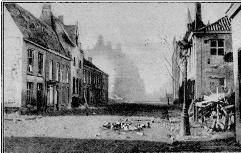
Nieuport a bombázás alatt.
