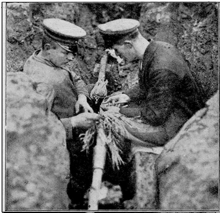
Földalatti kábelvezeték javítása.
