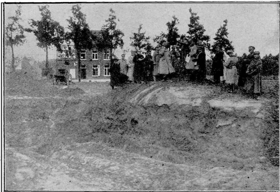
A negyvenkettes mozsár helye. Az óriási gödör mögötti fák lombjai a légnyomástól lehullottak. A házak tetőzete összeroppedezett.
