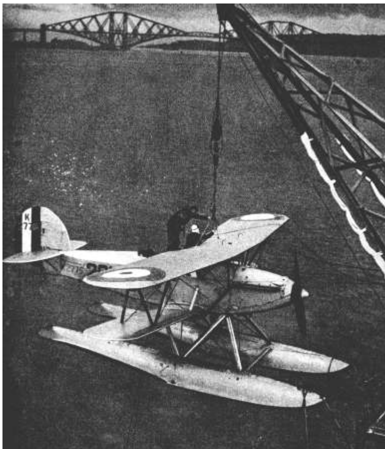
VÍZIREPÜLŐGÉP, FUTÓSZERKEZET HELYETT ŰSZÓSZERKEZETTEL. VÍZRE SZÁLL LE ÉS UGYANONNAN REPÜL FEL.
