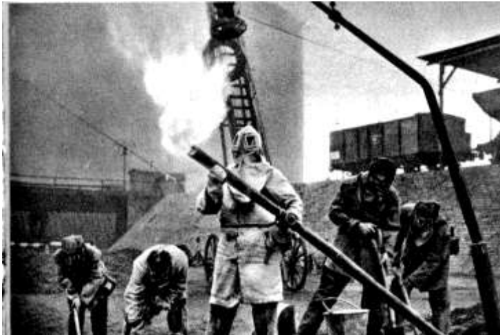
VENDÉGLŐ ELSŐTÉTÍTÉSE. ÖSSZEROMBOLT ÉS MEGGYULLADT GÁZVEZETÉK MEGJAVÍTÁSA.
