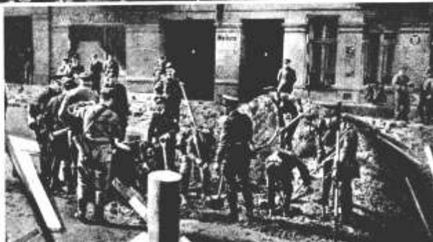
LÉGOLTALMI MŰSZAKI OSZ- TAG. KÜLÖNLE- GES SZAKKEP- ZÍTTSÉGU SZE- MÉLYZET MEG- RONGÁLT GAZ- VEZETÉKET JA- VÍT.
