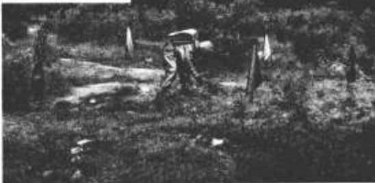
A GÁZFELDERÍTŐ MUSTÁR- GÁZZAL FERTŐZÖTT FAL- VELEKROL KÉPPROBAT VESZ.
