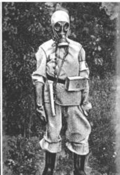
GÁZFELDERÍTŐ JÁRÓP EMBERE GÁZKÉMLŐ KESZÜLÉKKEL.
