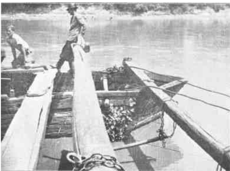
2. A rápolti vízimalom tiltósára (középen), mely a tiltót két láncon tartja, (A tiltó nem látszik). Ennek (külső) kantárját az első palló tartja. A tiltósártól balra a középső palló. Hátul a grand-hajó.
