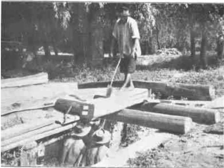
2. Gerendafűrészelés kézierővel az olcsvaapáti hidasépítő telepen. Felső-magyarországnak ez az egyetlen, szerte az országban ismert komp- építő műhelye.
