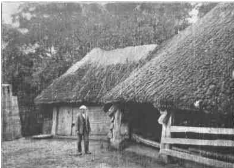
1. A matolcsi szárazmalom a Hótszamos partján. Ennek a vidéknek ez az utolsó működő, jó állapotú szárazmalma. Ma már az alföldön ritkaságszámba mennek. Elöl Szabó József szárazmolnár.
