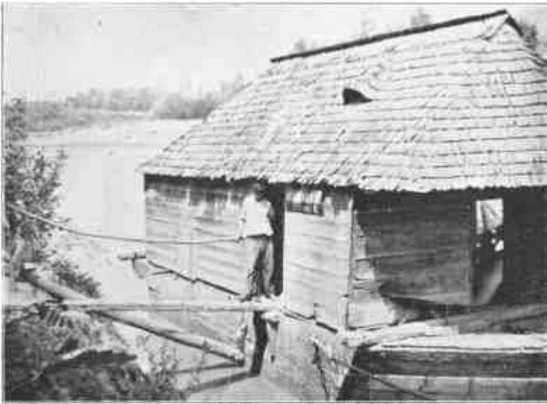
1. Az utolsó hajómalom a magyar Szamoson, a rápolti part alatt. A bejáráthoz karos palló vezet, azontúl a nyomó fa s az ajtóban Habarics József vízimolnár. A malomház másik oldalán van a nagy vizes kerék.
