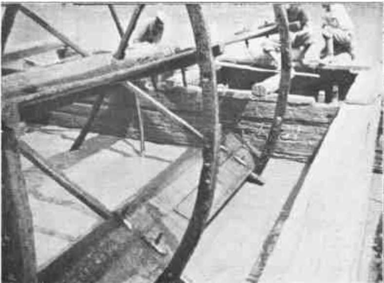
2. A rápolti hajómalom nagy vizes kerekének középső és külső koszorúja, a nagy gerendelyből kinyúló keresztág-küllő és lapockadeszka alkatrészekkel. Utóbbiak veszik át a folyóvíz hajtó erejét.
