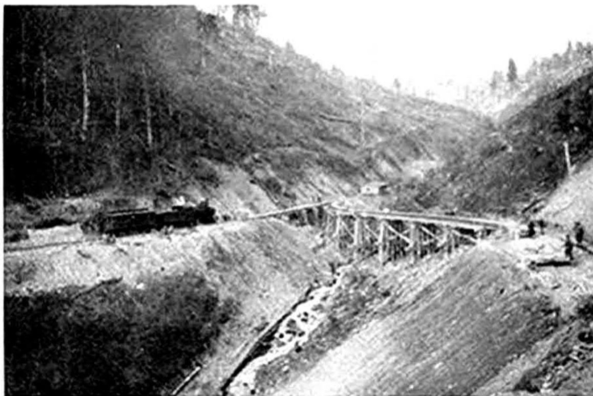
A: uzsoki szétrombolt vasúti hid és a kisegítő vágány.
