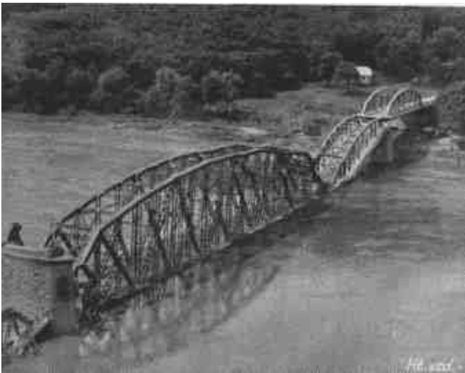
A felrobbantott Dnyeszter-híd.
