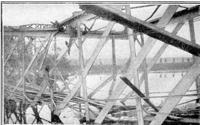
Felrobbantott vasúti híd a Bugon Breszt-Litovszknál. A folyó tulsó partján a 16. honvéddalagezred járőre látható, amely elsőnek nyomult be a várba.
