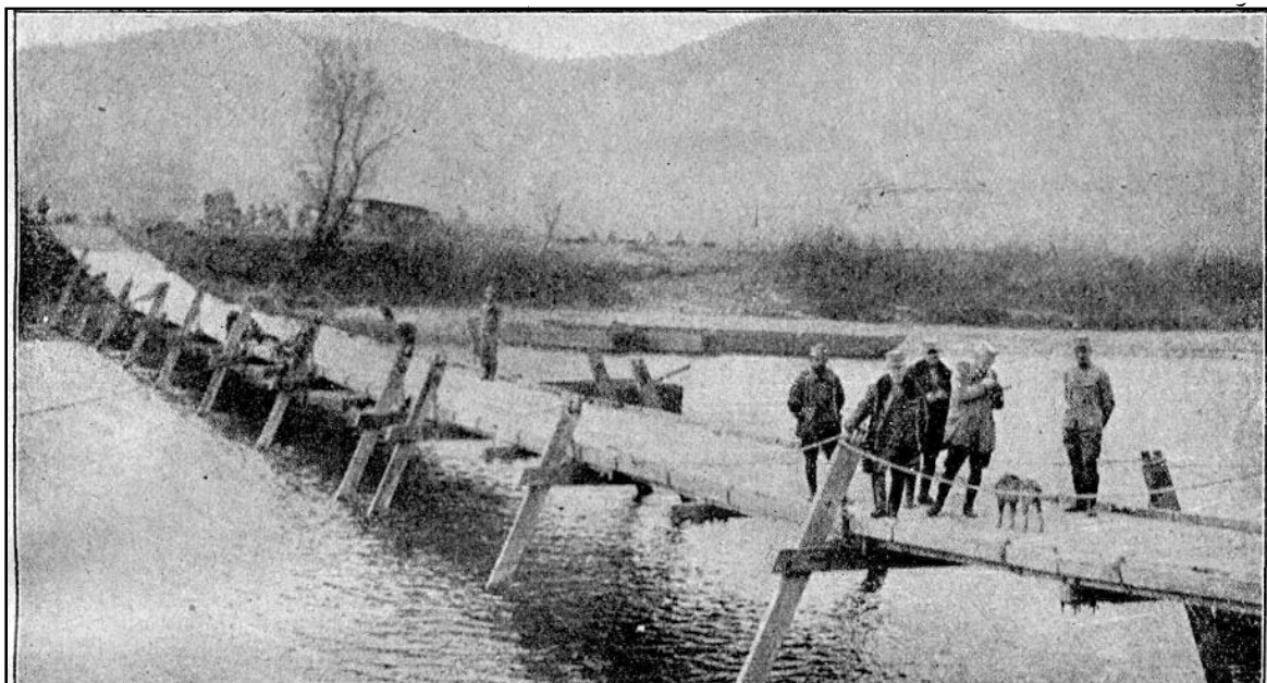
Hidásaink által két óra alatt felépített hadihíd.
