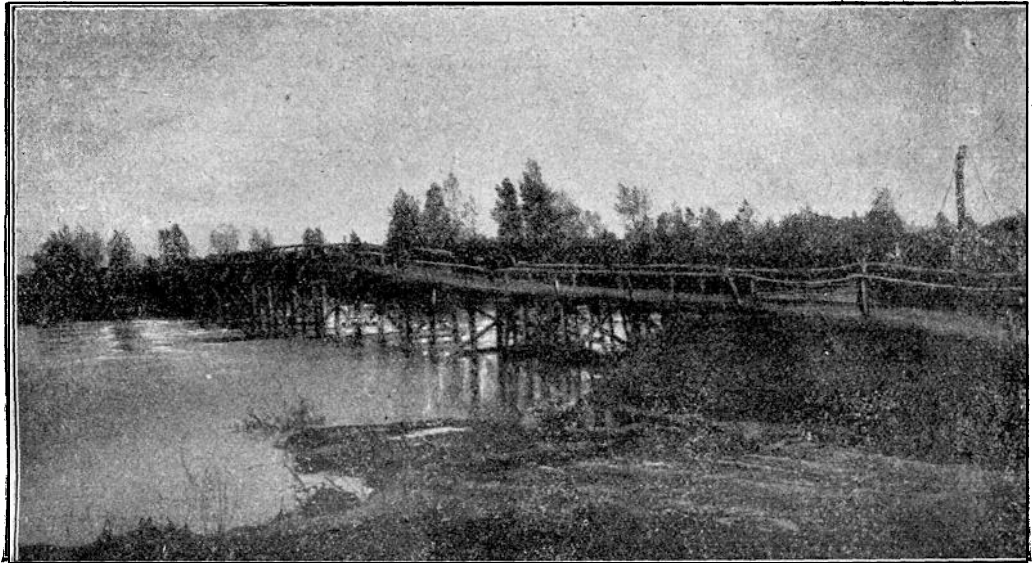
Híd a Vislokán át, Savluszovice mellett.
