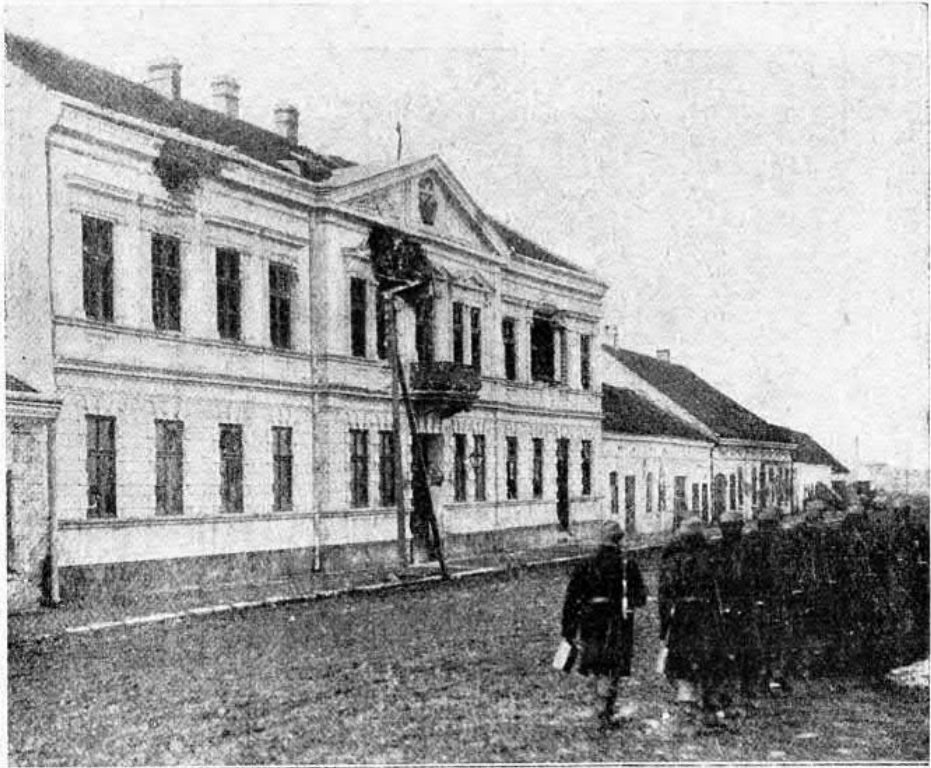
A szerb-mitrovicai vámpalota, amelyet lüzereink ágyúgolyói nagyon megrongáltak. A palota homlokzatát meg kellett támasztani, hogy a fal ne dőljön
