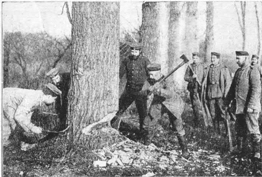
Nemet utászatonák munkában. Hatalmas fákat vágtak ki részben hidépítéshez, részben a lövészárkok falainak a befödésére
