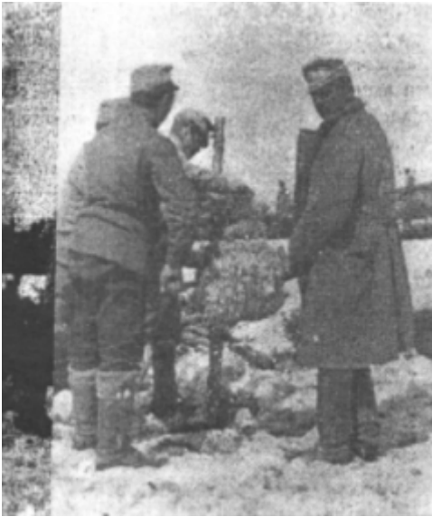
Drót akadály-építés Gorlicén.
