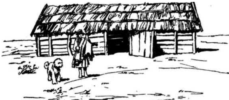
90. ábra. Disznóhodály. Fala deszkából, fedele nád hiányában kukoricából készült. Túrkeve—Ecseg.
