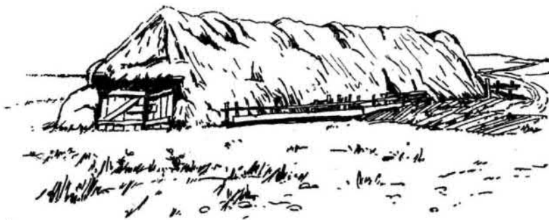
88. ábra. Szalmatetejű juhodály. A hosszú szaljnakawilszerű épület váza nyerges tetőgerendából, rudakból, lécekből van összeróva. Nagy kétszárnyú deszkaajtóval. Apa.
