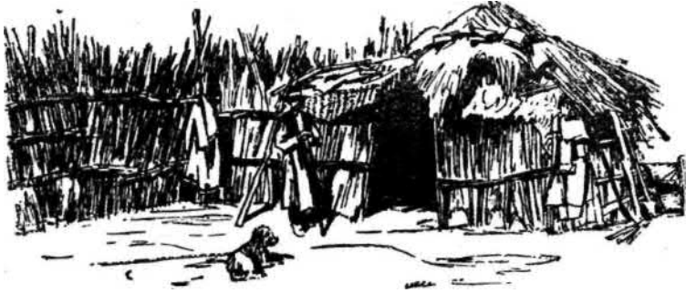
122. ábra. Nád kunyhó szövött gyékénytetővel. A kunyhó a szárnyék falához csatlakozik. Kunmadaras.
