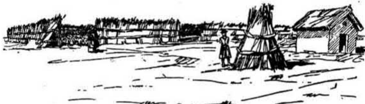
62. ábra. Háromrekeszes juhkarám. 500 kéve nádból készült; 800 főnyi juhnyáj befogadására alkalmas. A két szélső fiók bejáratánál a kutyák számára enyhely van. Az előtérben vályogból készült nád-fedéles juhászkunyhót és nádból készült vasalót (főzőkunyhót) látunk. Ilyen nagyszabású karámot csak uradalmak építenek. Nagyiván.
