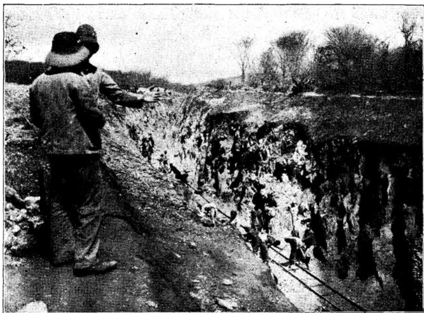
A központi vasút építése. Sziklabevágás munkavágánnyal.
