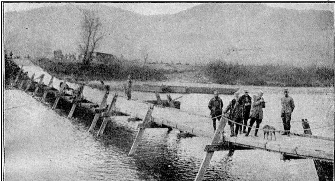
Hidásaink által két óra alatt felépített hadihíd.
