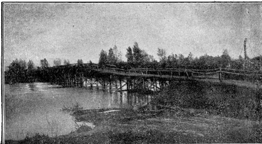
Híd a Vislokán át, Savluszovice mellett.
