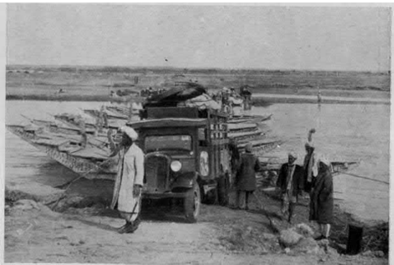
Girisk. Átkelés a Helmeden. Balra az épülő híd pillérei.
