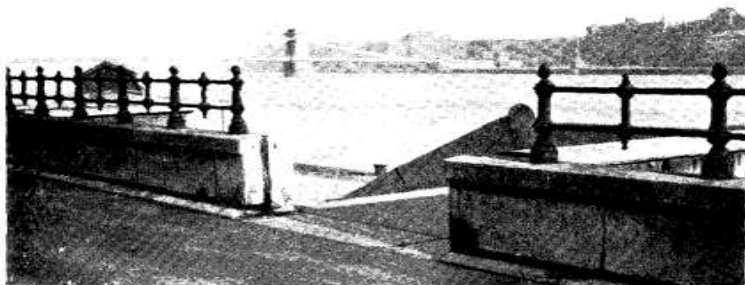
1. kép. Mellvédfal a Dunaparton. A képen látható rovátlékba helyezett fatáblákkal a korlátfal nyílásait el lehet zárni úgy, hogy az a rendkívüli árvizek ellen is védelmet nyújt. Az 1838-i árvíz magassága helyenkint meghaladta még ennek a korlátfalnak a tetejét is.
