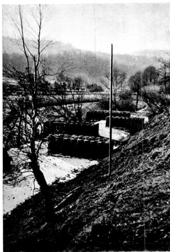
Járműterelő. Utászaink építették.
