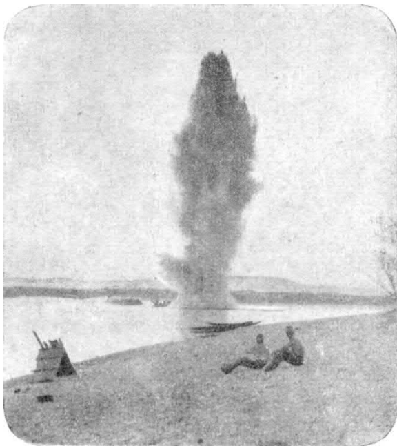
A simiáni folyamzár 500 kg. ekrazittal történt eltávolítása.
