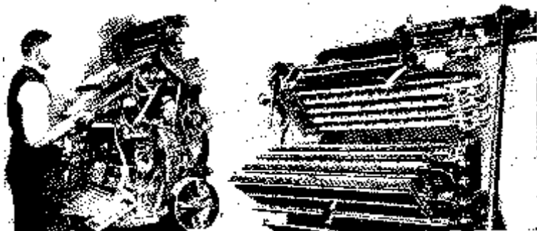
Magazincsere. — Jobboldalt: az új, négymagazinos Linotype négyosztószerkezetes lerakója, mely önműködőleg osztja vissza mind a négy magazinba a megfelelő betűmatricákat.
