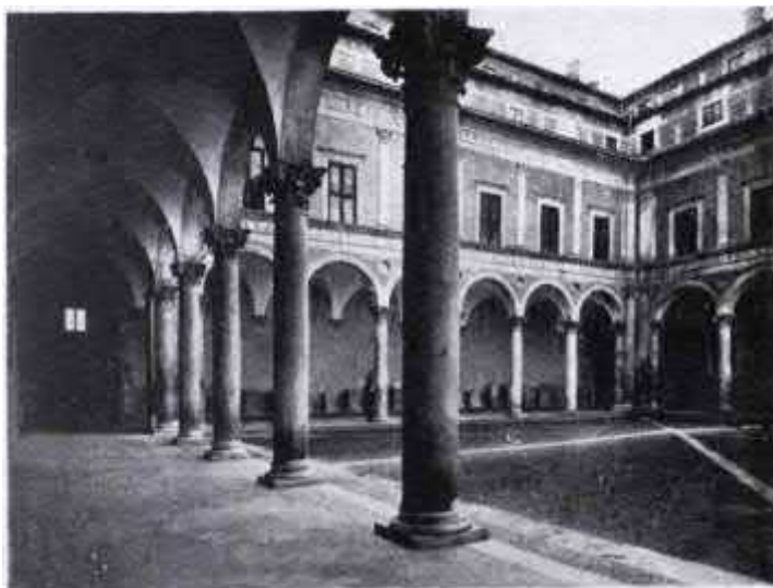
A Palazzo Dacaié udvara Urbinóban.
