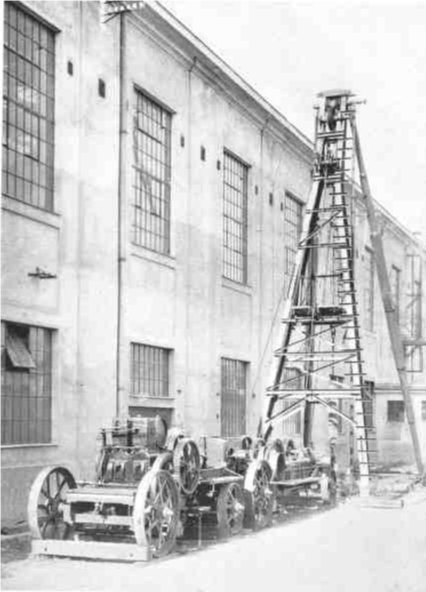
28. Ivóvízszerzés az új állami kútúróval.
