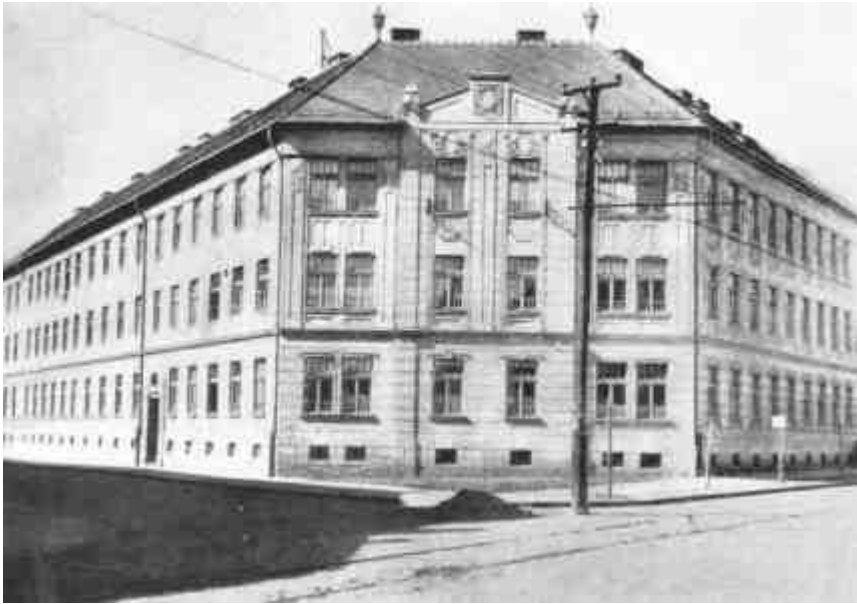
15- Városi építkezés, Miskolc.
