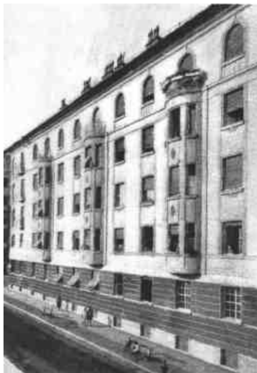
9. Márvány- utca, Budapest. Állami lakóház.
