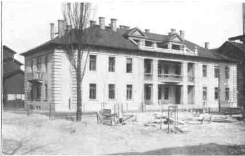
45. Állami gyermekmenhely, Budapest. Az új melléképület.
