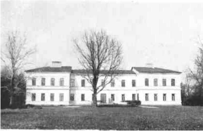
79. Tüdőbajos gyermekek gondozó intézete, Deszk. Kert felőli homlokzat.
