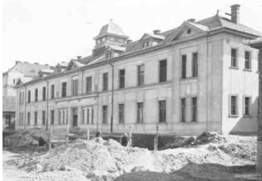
86. Madarász-utcai csecsemőkórház, Budapest. Építkezés alatt.
