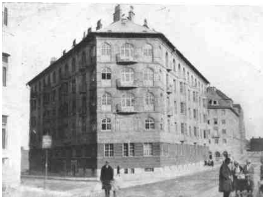
7. Márvány-utca, Budapest. Állami lakóház.
