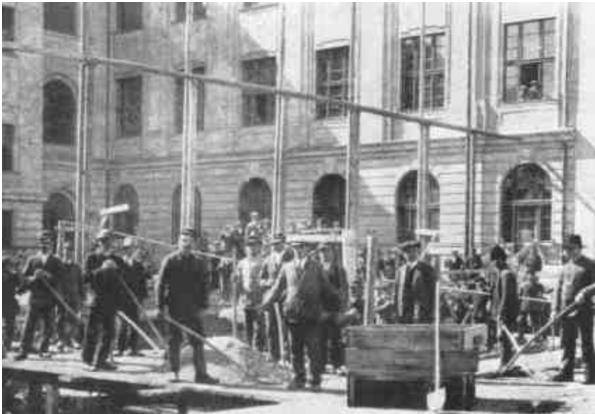
16. Városi építkezés, Győr.
